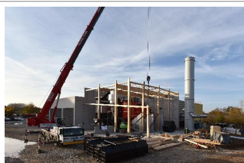
Construction de la chaufferie biomasse – crédit O. Barrau
